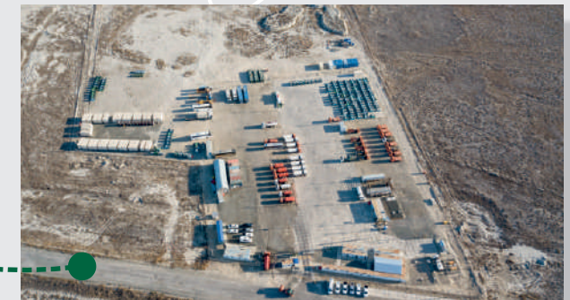
Комплекс по обращению с отходами «Тенгиз»
