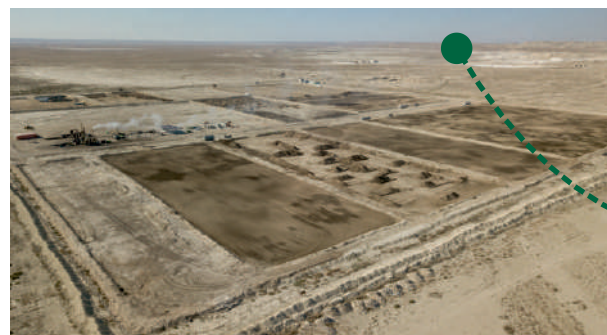
Комплекс по обращению с отходами «Узень»
