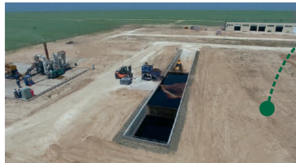
Комплекс по обращению с отходами «Кошанай»
