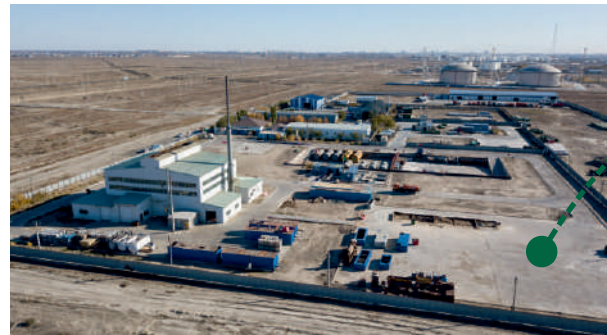
Комплекс по управлению отходами
