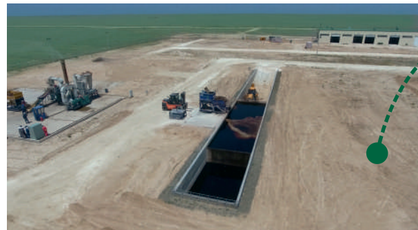
Комплекс по обращению с отходами «Кошанай»
